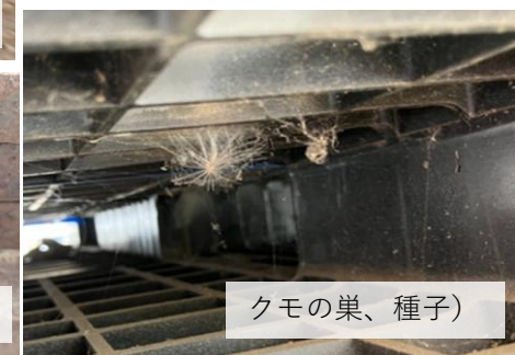
目視点検で発見された付着物
