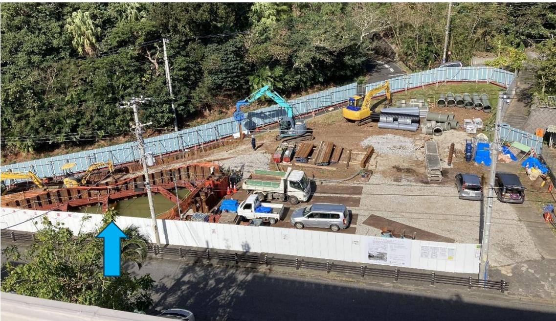
工事用地から発生する場内土砂等を含んだ濁った水を一時的に貯水し、水質を管理した上で清瀬川に排水する施設である。
