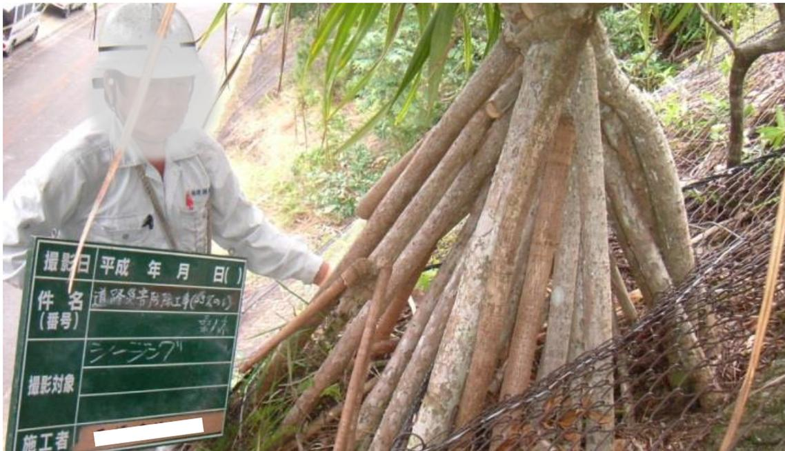
斜面の落石対策で落石防止網を設置する際に、保全対象植物がある場合には、網に穴を開けて生育を妨げないようにしている。
