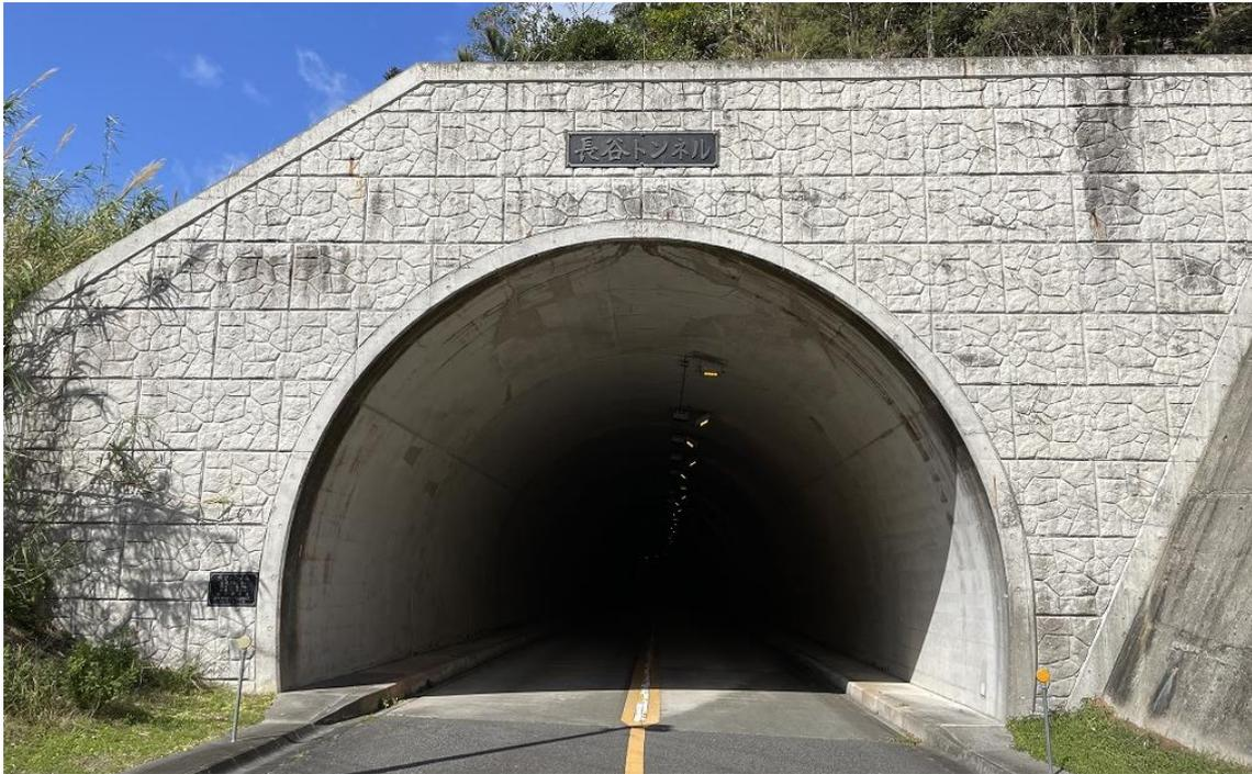
道路のトンネル入口の擁壁などに化粧型枠を使用し、景観に配慮している。
