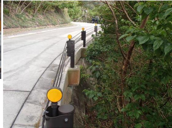
施工条件が厳しい箇所において、張出ブロックを利用した道路整備を行うことで、工事による自然環境改変の影響を軽減する。
