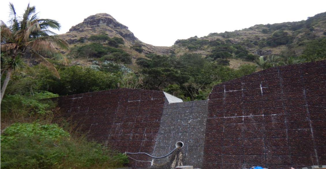
砂防堰堤や護岸、擁壁などに化粧型枠を使用し、景観に配慮している。
