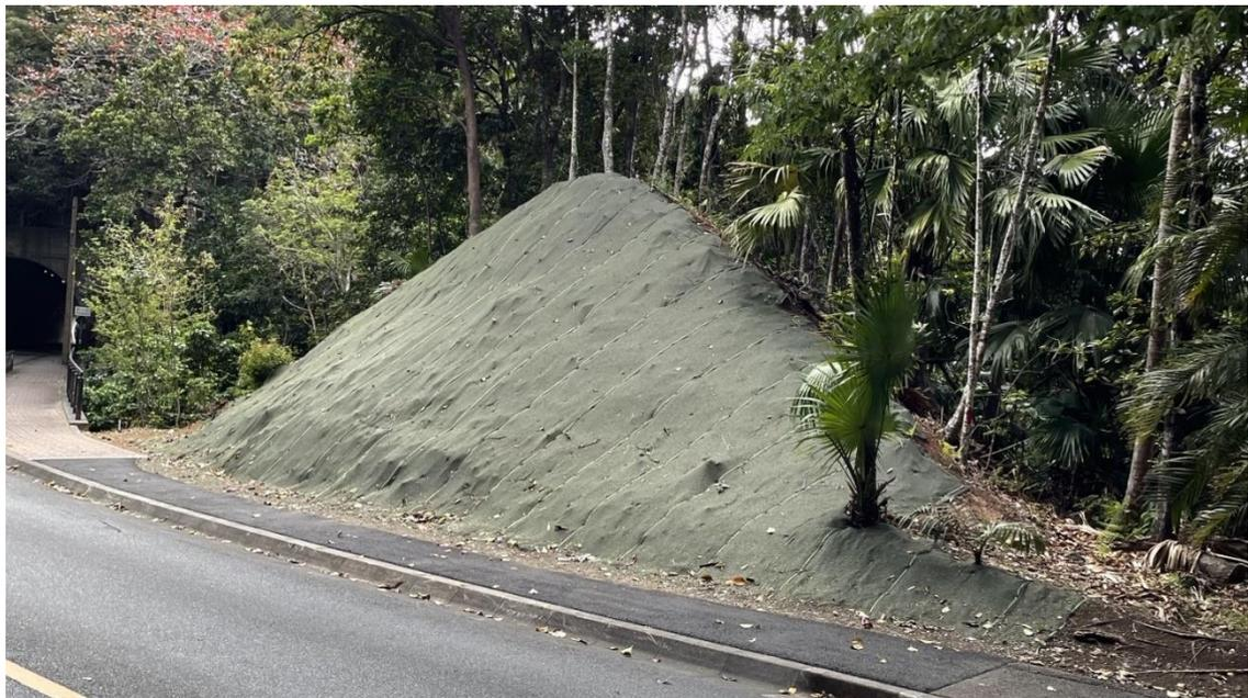
法面の土砂流出防止と早期緑化を図るため、養生シートを設置し、植物の発芽・生育を促すとともに、景観にも配慮している。
