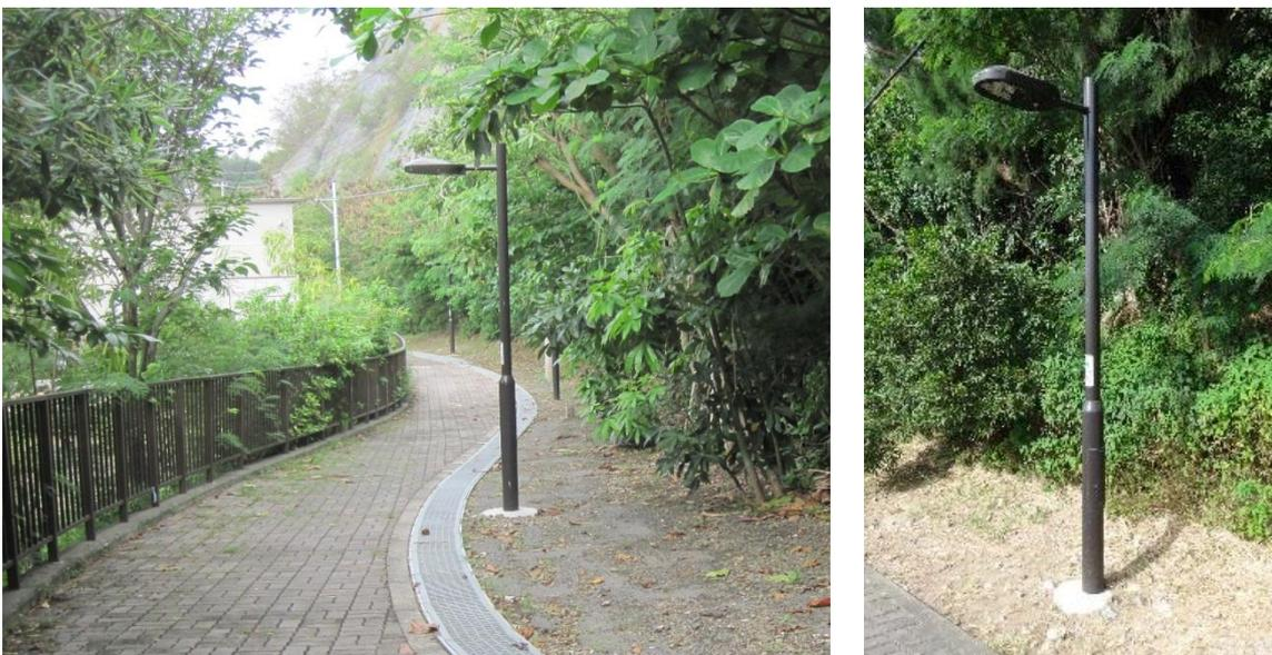
ウミガメが産卵のために上陸する際に、光によって上陸を阻害しないように橙色のLEDを採用するとともに、海側に光が漏れないようにフードで覆っている。また、照度をさほど必要としない場所では、手すりに埋め込んだり、照明灯具の高さを低くしたりするなどして、できる限り光を拡散しないように配慮する。
