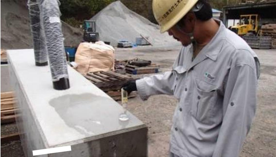
工場打設したコンクリートを使用することで、現場施工の短期化、簡素化を図り、濁水や、アルカリ排水などの流出を防止する。
