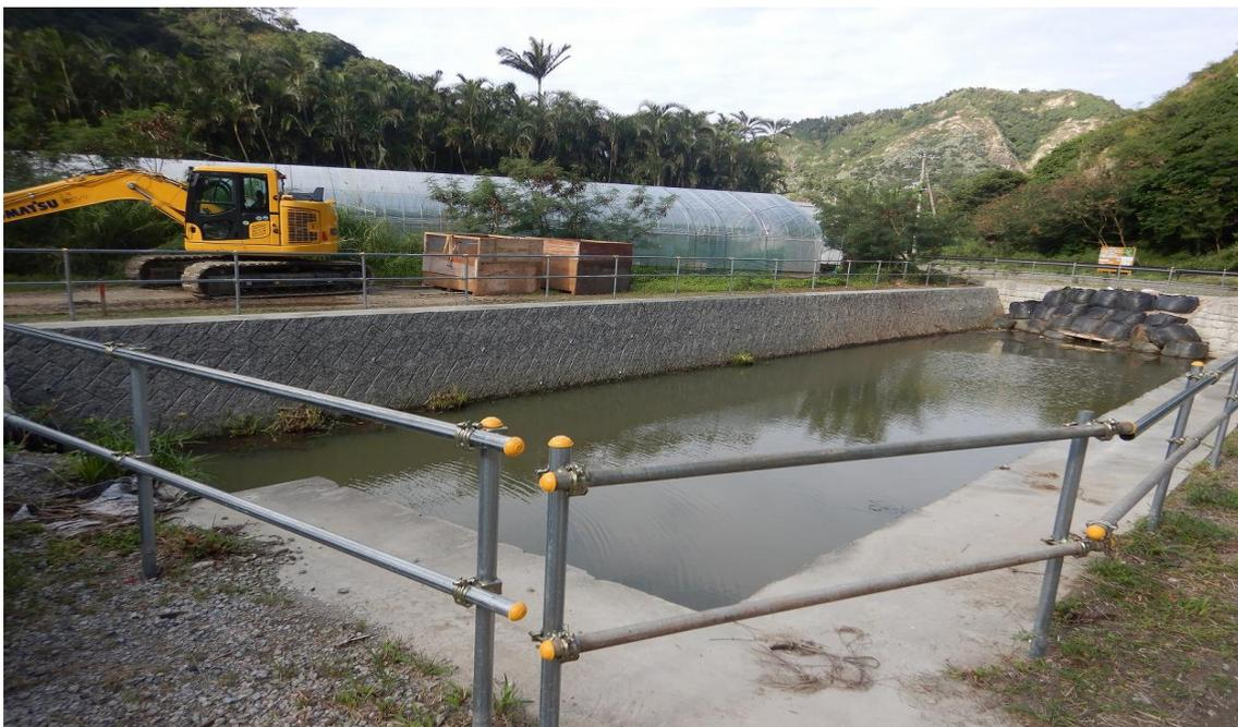
沈砂池を設置し、濁水の河川への直接流入を防止し希少な水生生物を保全する。
