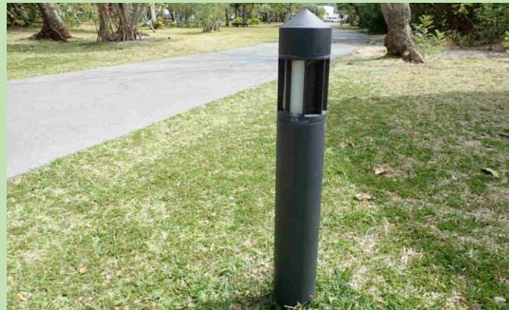
海に近い場所はフットライト（LED）を設置。ウミガメに配慮した光源と波長とした。海側には光が行かないよう海側にカバーを設置。
