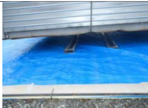
地表面から浮かして設置
