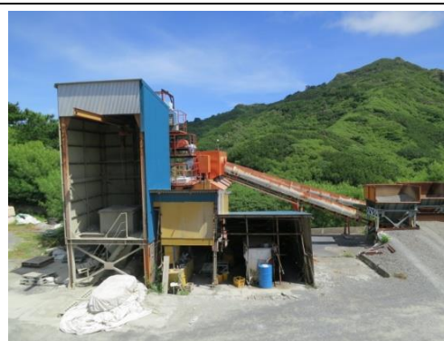
写真2 日章建設プラント
