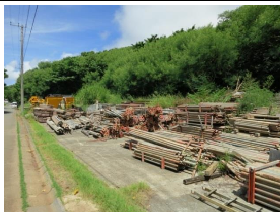
写真 5 夕日ヶ丘仮設資材集積場
