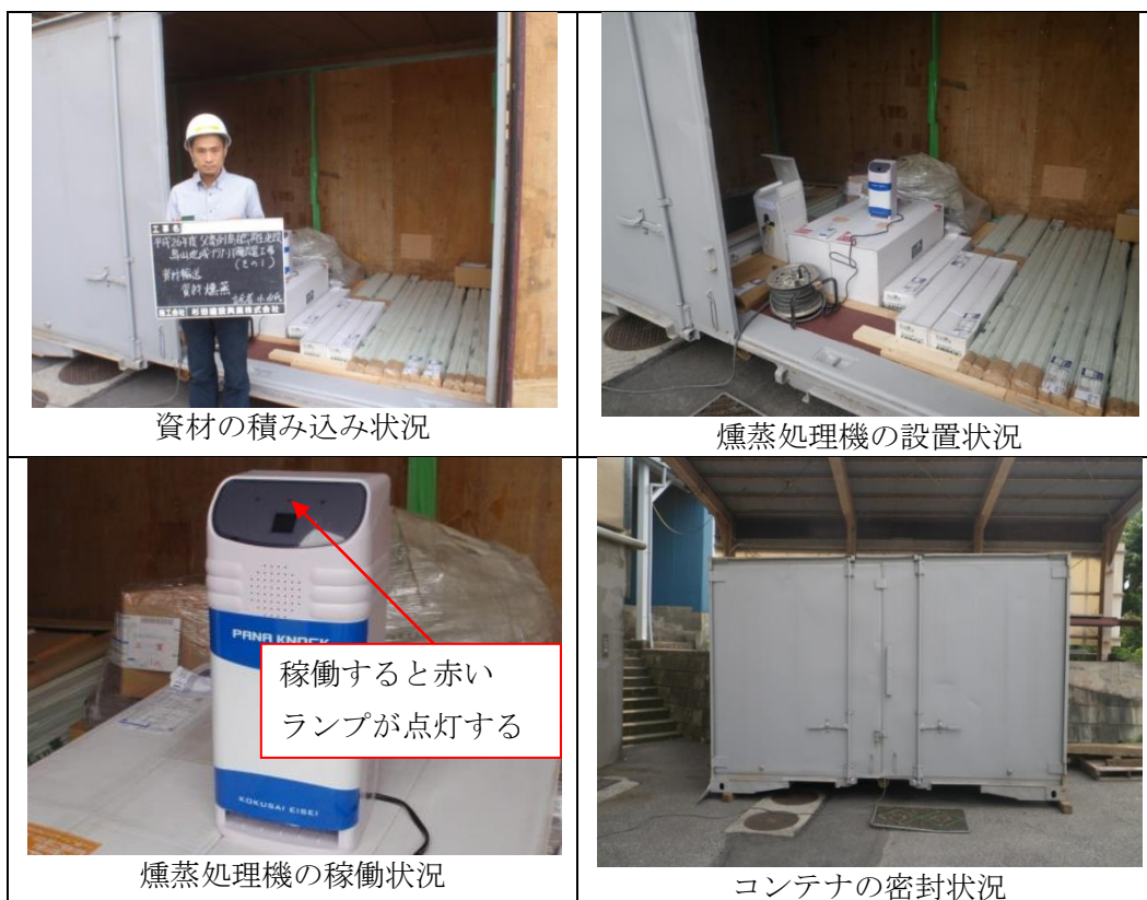
写真4 資材の積み込み及び燻蒸処理の状況
