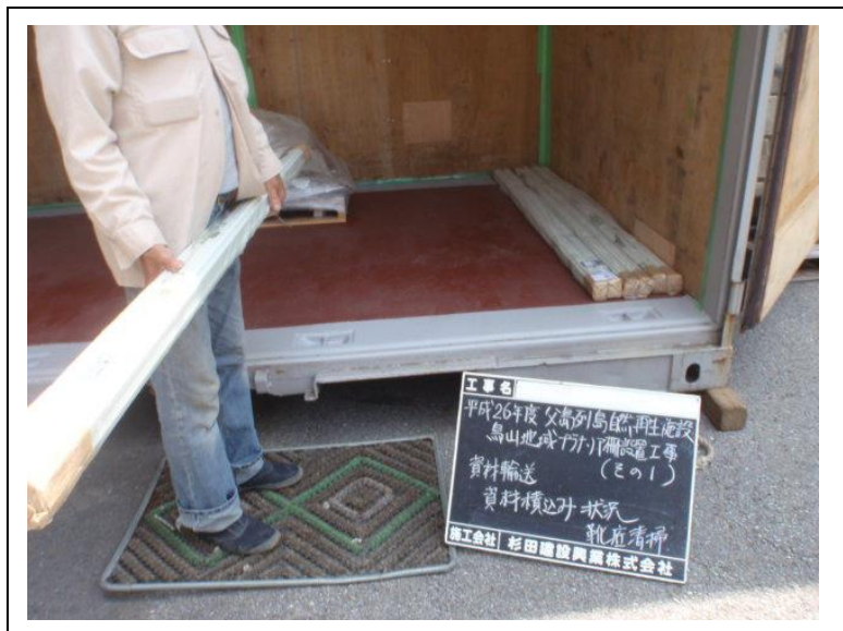
写真3 泥落としマットの使用状況
