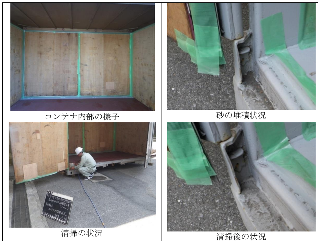
写真1 コンテナ内部の目視点検の状況
