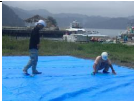
ブルーシートの敷設
