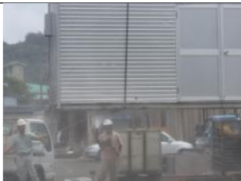
コンテナ下部の洗浄
