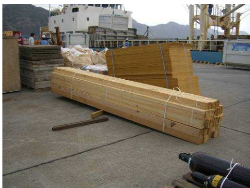
■荷下ろしされた資材等
