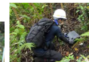
BSの設置作業
