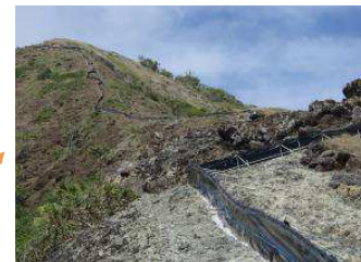
鳥山地域におけるプラナリア侵入防止柵の設置（H27.3完成）
