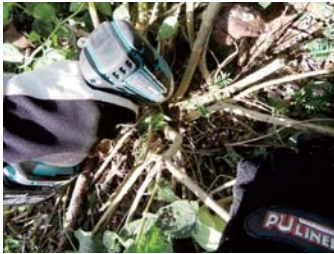
ドリルによる穴あけ
