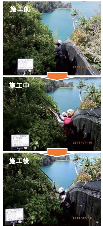
在来樹木切上げ 施工状況
