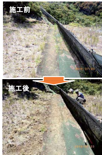
草本刈込等 施工状況
