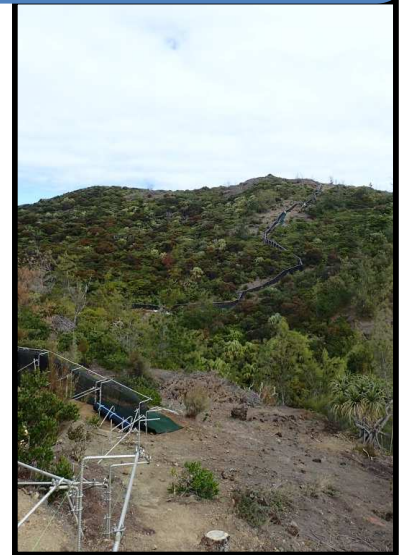
Cライン施工状況
