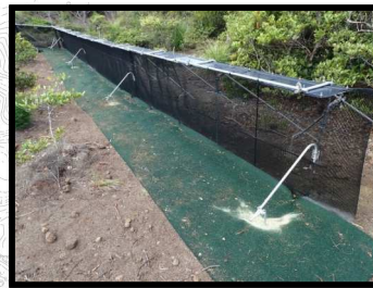
Cライン完成状況
