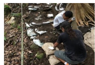
土嚢袋の設置
