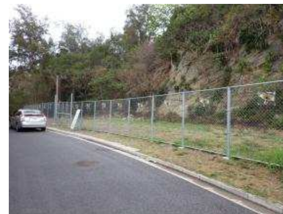
バードセイバーの設置
