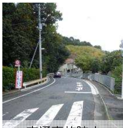
交通事故防止 注意喚起看板の設置
