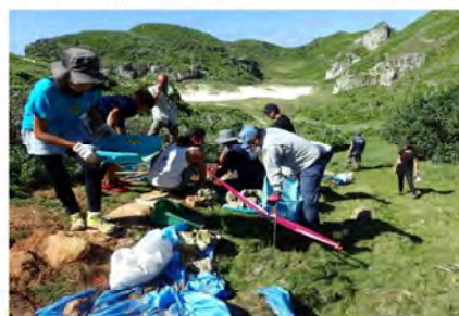
修繕作業実施の様子
