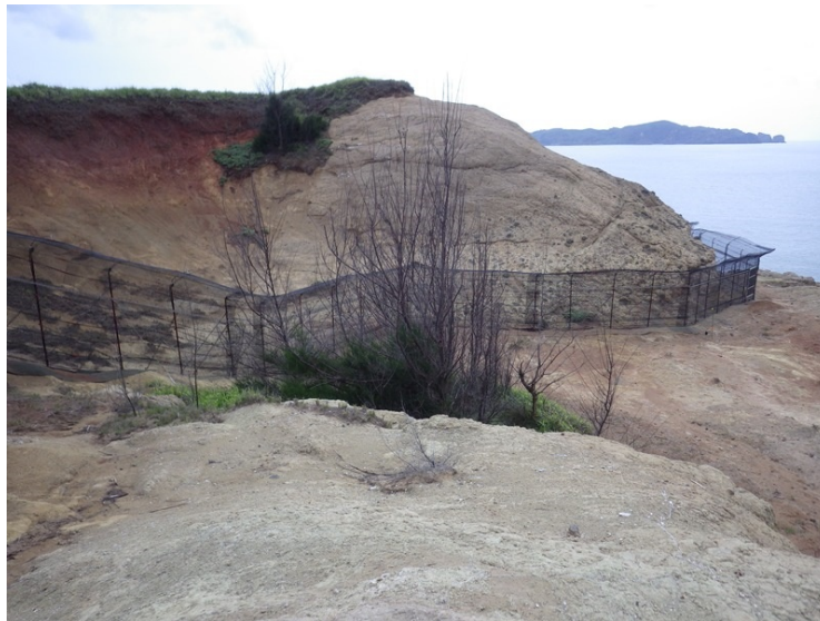
平成 28 年 5 月 母島南崎に再整備したノネコ侵入防止柵
