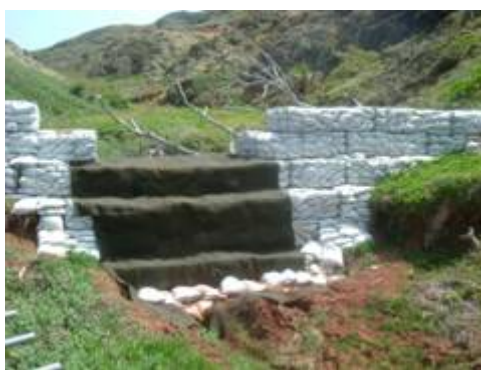
小規模なダムの設置状況
