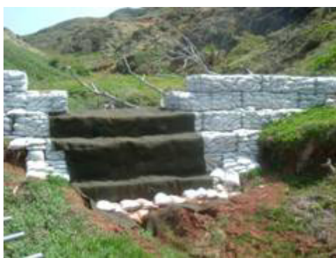
小規模なダムの設置状況
