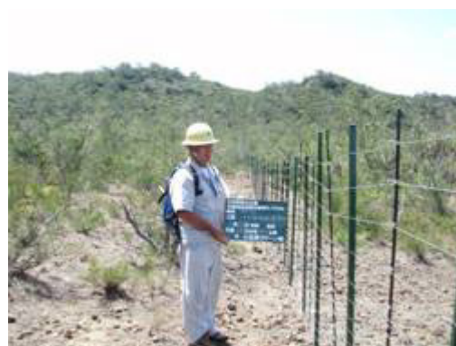
分断柵の設置状況
