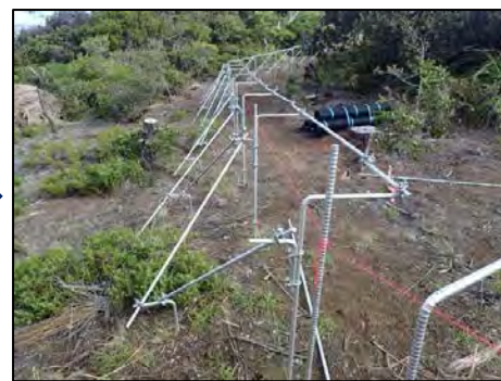
図 支柱の建込作業 (貴重種に留意しライン決定、支柱建込)
